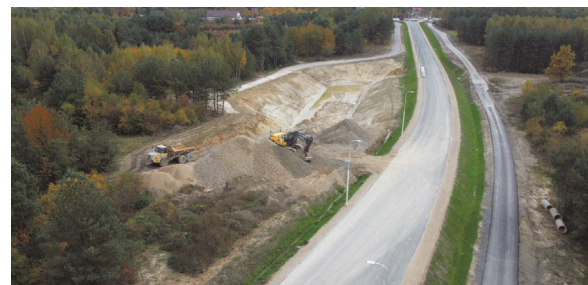
Końcowy fragment obwodnicy. W oddali widać rondo łączące ją z drogą do Staszowa.
