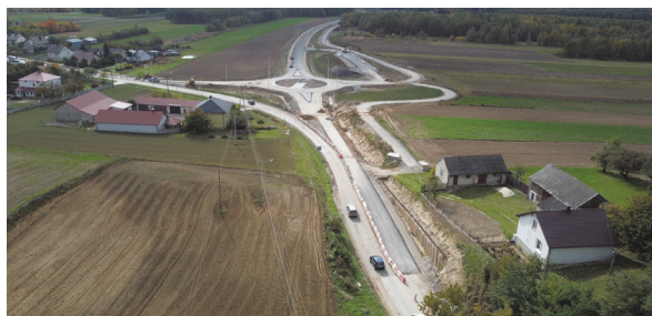
Początek obwodnicy. Rondo w miejscowości Kielczyna
